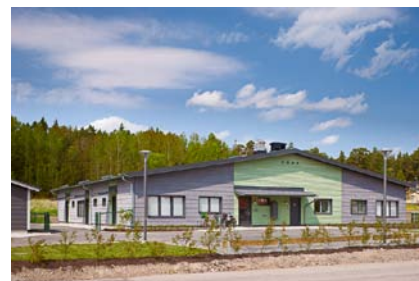
Det nybyggda gruppboendet Smörsoppen slutfördes under 2012.
