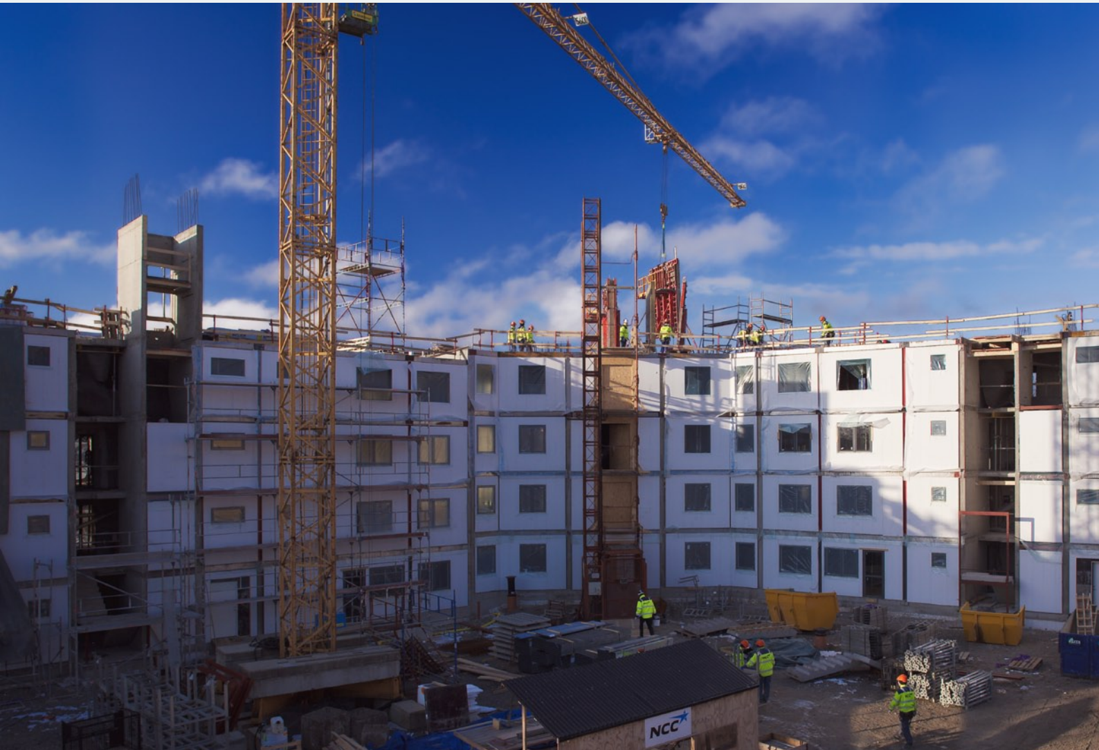
Vasagården under byggnation, morgonen den 24 mars 2009.
