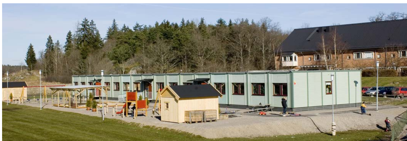
I Mariefred uppförde bolaget, på mycket kort tid efter beställningen, denna 3-avdelningars barnstuga, som är ett provisorium avsett att användas under minst två år, i avvaktan på att vi hinner bygga ikapp behovet, som hela tiden ökar i Mariefred. Inflyttningen skedde i november 2006.
