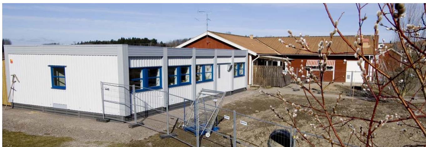
Även i Åker har vi fått i uppdrag att lösa akuta behov. Där löste vi problemet genom att bygga ihop denna paviljong med den befintliga förskolan "Tomaten". Inflyttning skedde i januari i år. Det här är också en provisorisk lösning, som beräknas kunna avvecklas redan i höst.
